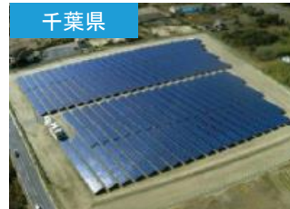
S-06 LS匝瑳発電所
