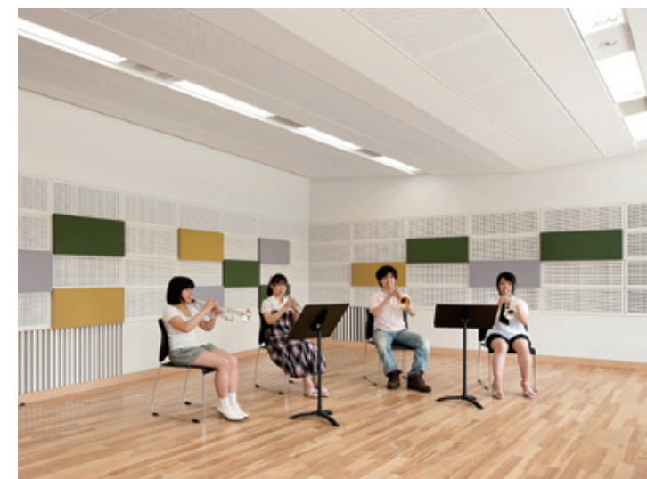
部屋の大きさにより室内形状や内装材が異なる大(L)小(M)のアンサンブル室。Lは吸音カーテン、Mは可変吸音板で音響調整を行う。
