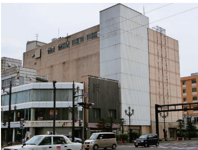
釧路の大通りに面した廃デパートと廃店舗、 廃テナントビル
