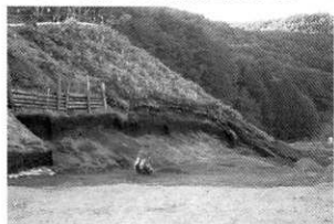
4. 平成20年度T3-T1段丘崖掘調査終了状態 (SE→)
