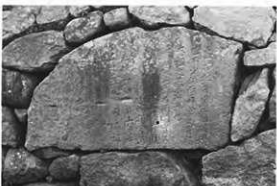
写真 46 富久浦久保屋敷跡石垣
