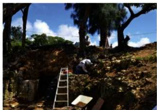
作業風景 (略南東より)
