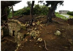
袖回り (南東から)
