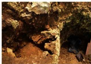
東側袖石積み 岩盤状況 (略南西より)
