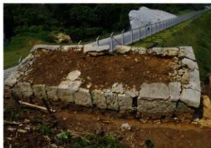
屋根後方 検出状況 (南から)
