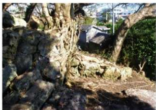
袖石 庭積み 検出状況 [西から]
