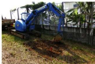
重機による表土掘削
