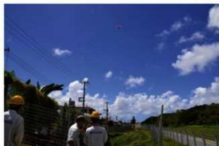
ドローンによる写真測量
