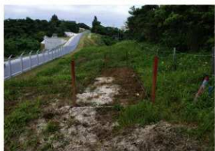
着手前状況 (南西から)
