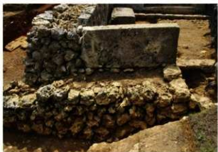
墓の門 石積 (北から)
