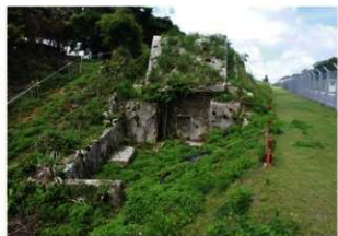
着手前状況（北東から）
