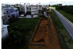
高所作業車による写真撮影
