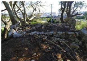
屋根 後方 検出状況 [北から]
