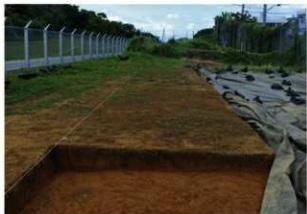
拡張部状況 (南西から)
