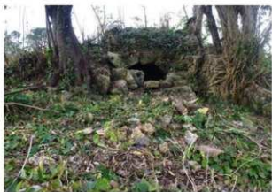
着手前状況 [南から]
