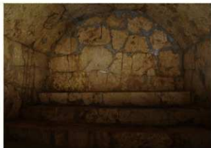
墓室内 掘削前現況 (北から)
