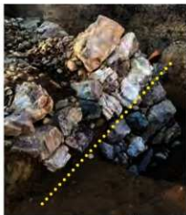
石垣表面の違い
