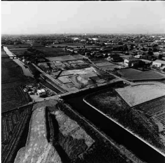
2 矢加部南屋敷遺跡 遠景 (南東から)
