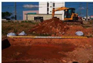
試掘坑No. 5 東壁
