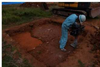
試掘坑No.3 埋戻し(転圧)
