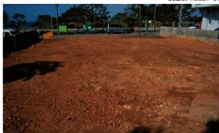
掘削後(南側から)
