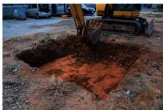
試掘坑No.2 重機掘削
