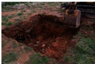
試掘坑No.1 重機掘削
