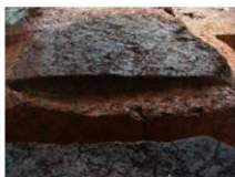
SK.01 半載状況
