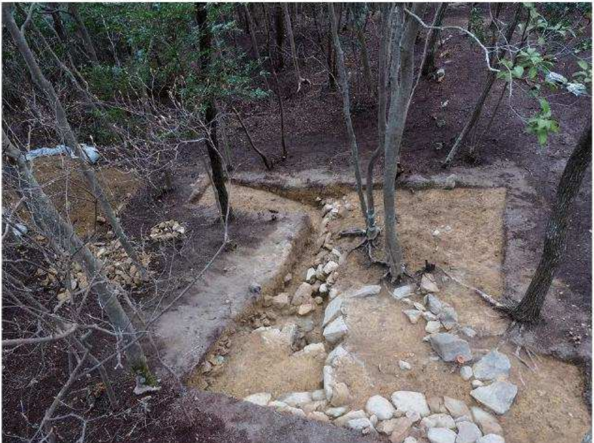
くびれ部調査区・前方部側 南東から。写真手前が後円部。前方部2段目斜面の基底石列は調査区外に露出した石材と一連のものとなり、前方部端へと続いている。
