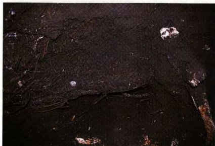
藤兵衛山遺跡崩落部分内部状況
