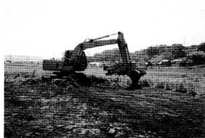
1 表土掘削風景
