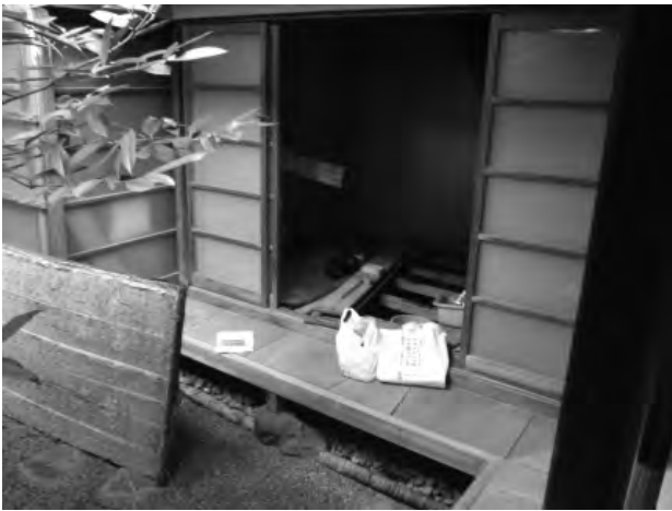
写真 3-14 調査箇所（東から）
