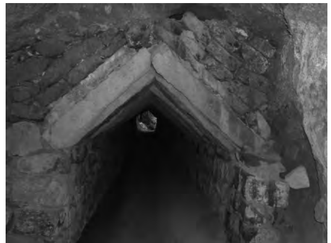
写真 4-8 川原隧道内部
