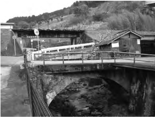
写真 4-6 現在の小月橋
