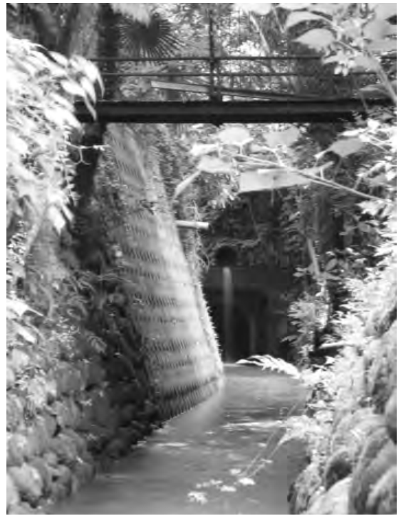
写真 4-1 現在も利用されている水路
