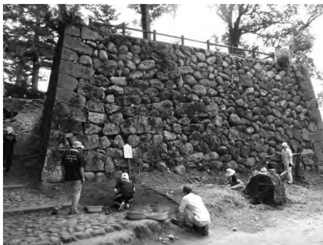
写真1-3 永山城本丸石垣の発掘調査の様子
