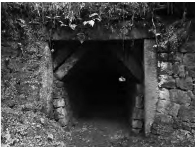
写真 4-7 川原隧道入口
