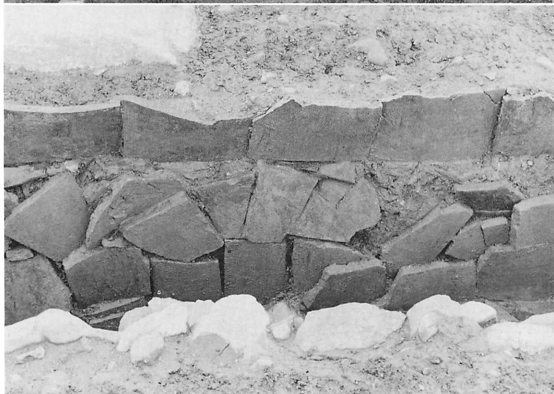
上：暗渠1北溝北側(南より) 下：同東溝西側(東より)
