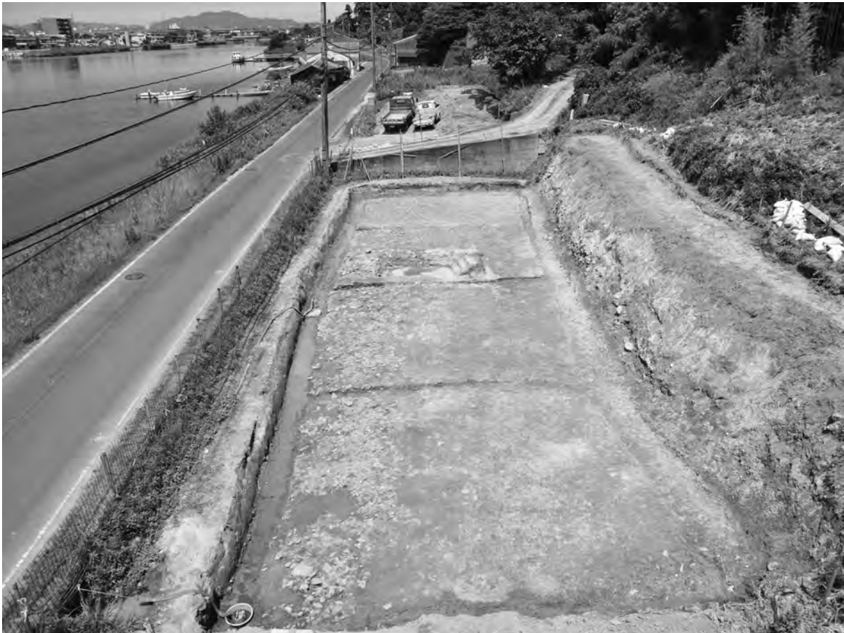
1. 若宮谷遺跡 B1区掘削後（東から）
