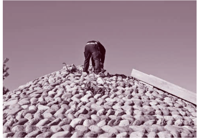
2. 平成 27 年度調査 表面コンクリート撤去作業（南東から）
