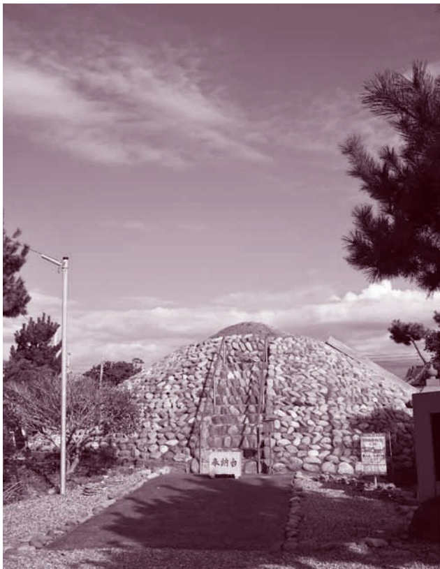
3. 平成 27 年度調査 表面コンクリート撤去後（南東から）
