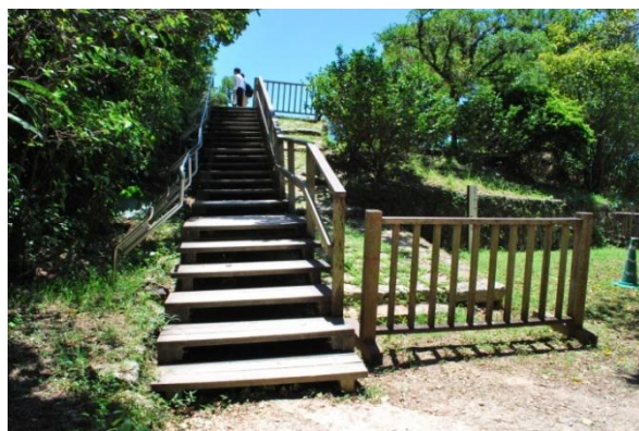
写真 2-20 御門口に設置されている仮設階段
