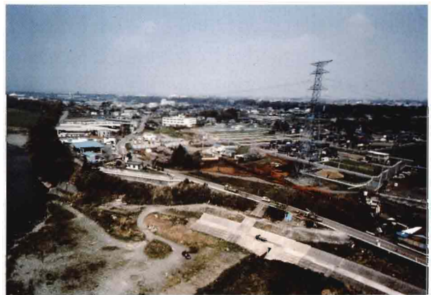
写真57 遺跡遠景(南側上空より)
