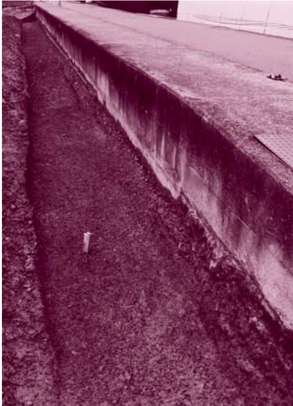
1 08019-2区完掘状況(北区 南東から)
