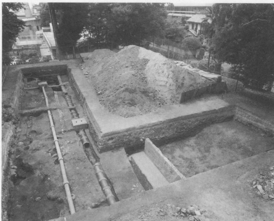
図123 調査区全景（東から）
