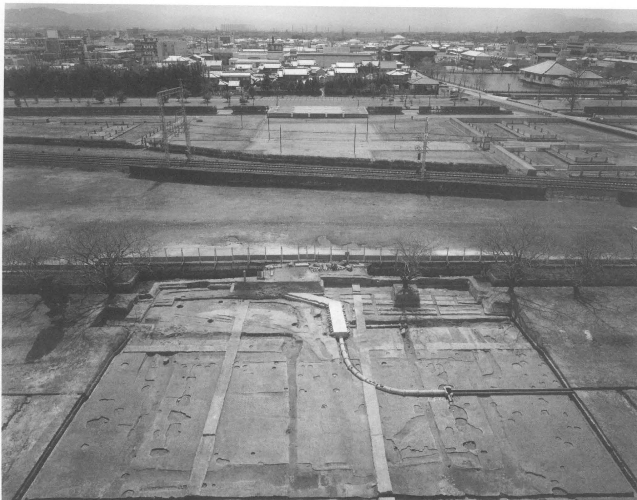
図86 調査区全景（北から）
