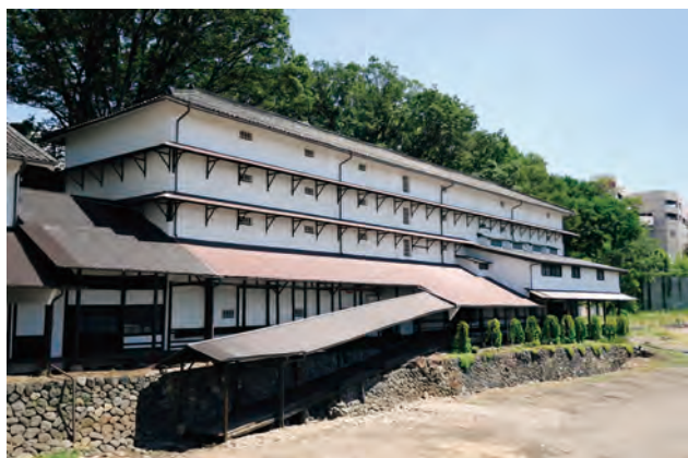
図3：木造五階建繭倉庫外観
