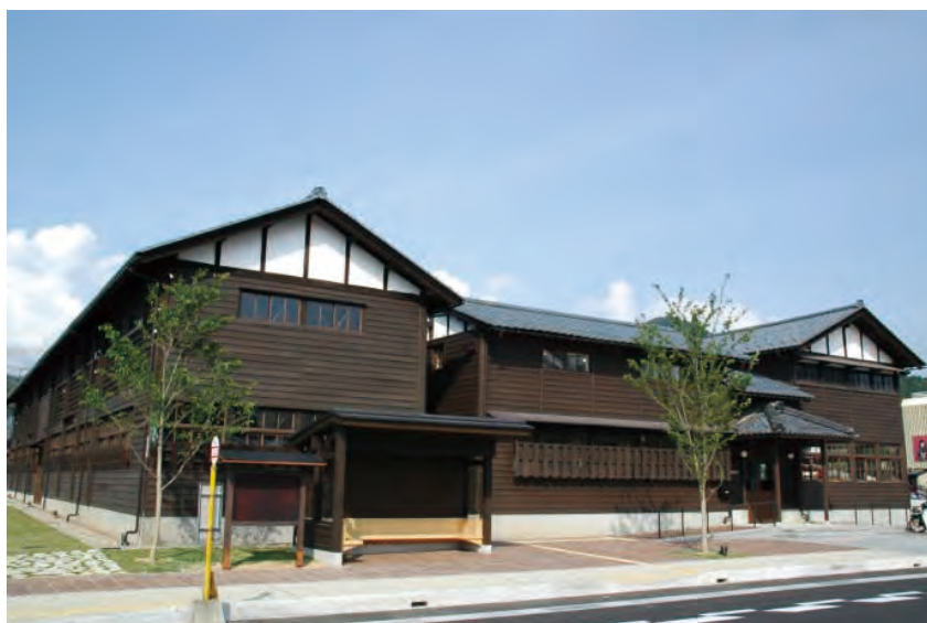
写真1 ゆめおーれ勝山正面全景
