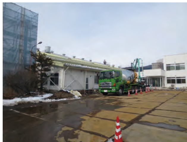
写真1 ミュージアムエリア・ファザードの基礎工事 （1月下旬撮影）
