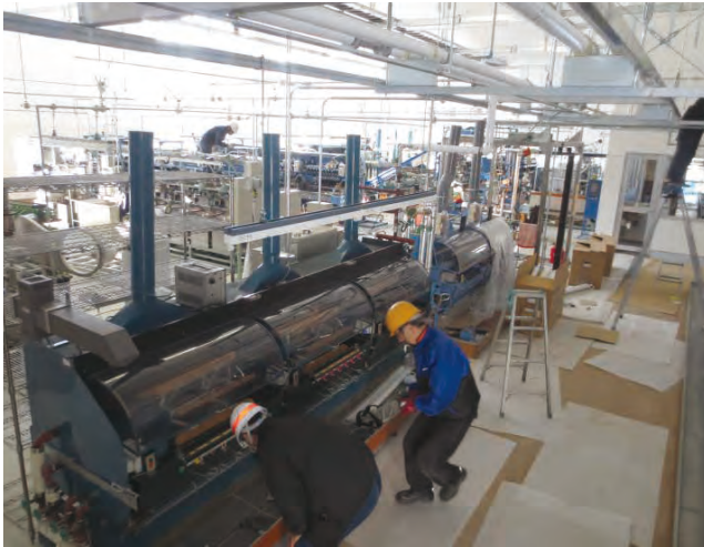
写真2 ミュージアムエリア内動態展示ゾーンでの 繰糸機械類の設置工事（1月下旬撮影）
