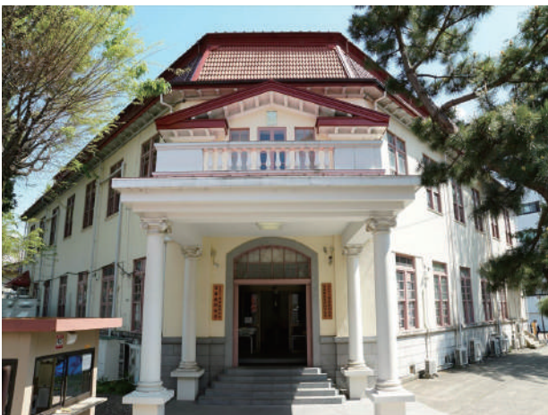
正門より見る1号棟の外観
