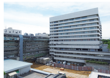
2014年5月 6号棟他解体跡地 (7号棟側から撮影)
