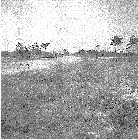
県営グランドより川崎アパートを望む (北川巖氏提供)
