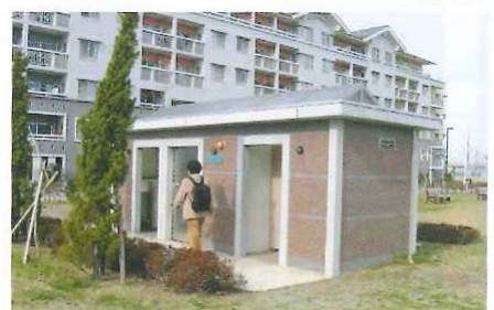
公衆便所（アクアダクトパーク）
