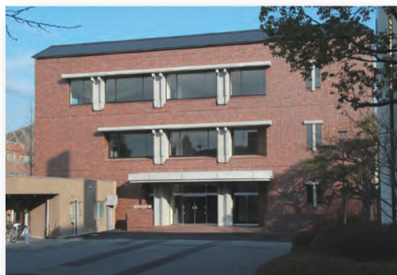
東部構内に完成した「ノートルダム館」
