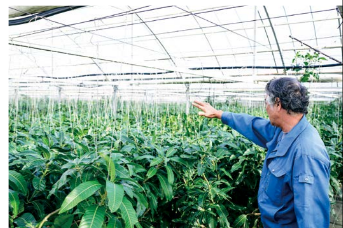
台風時の強風を想定して建設したハウスは、風速60メートルまで耐えうる設計。
