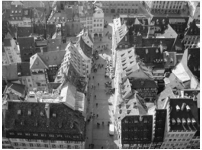
ストラスブールの町なみ（フランス） 関川華撮影
