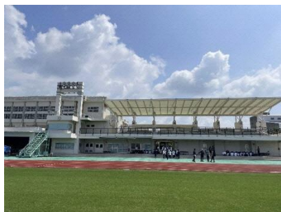
メインスタンド (金武町陸上競技場)
