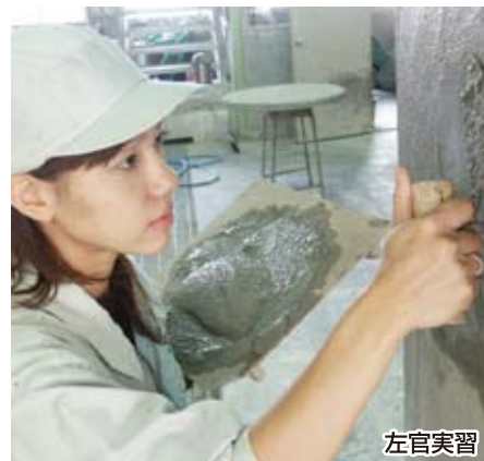
タイル貼り作業
