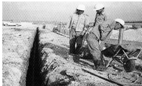
手作業による配水管布設工事
