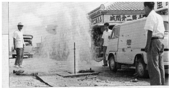
昭和 37 年 7 月 21 日給水開始（写真城間大通り）
