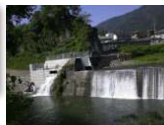
町営小水力発電事業 (1基、53kW)
