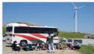
町営風力発電事業 (2基、1200kW)
