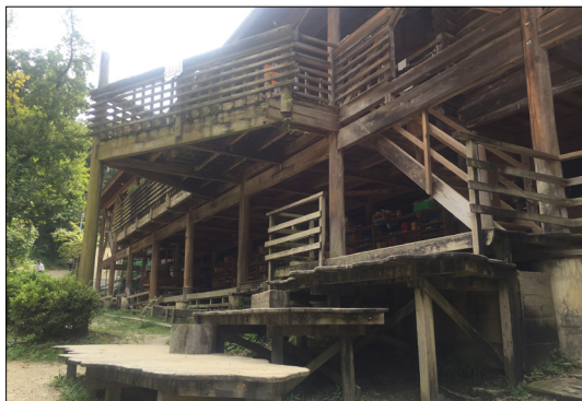
写真 4. 木造建築と風景
