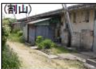
(割山) 構 造：簡耐平屋建 建設年度：S32～33 管理戸数：40戸
