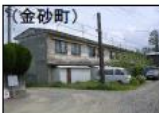
(金砂町) 構 造：簡耐2階建 建設年度：S29 管理戸数：12戸
