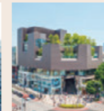
東急プラザ表参道原宿 所在地: 東京都渋谷区神宮前 竣工: 2012年4月
