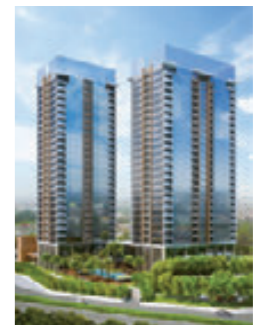
ジャカルタ「BRANZ Simatupang」
