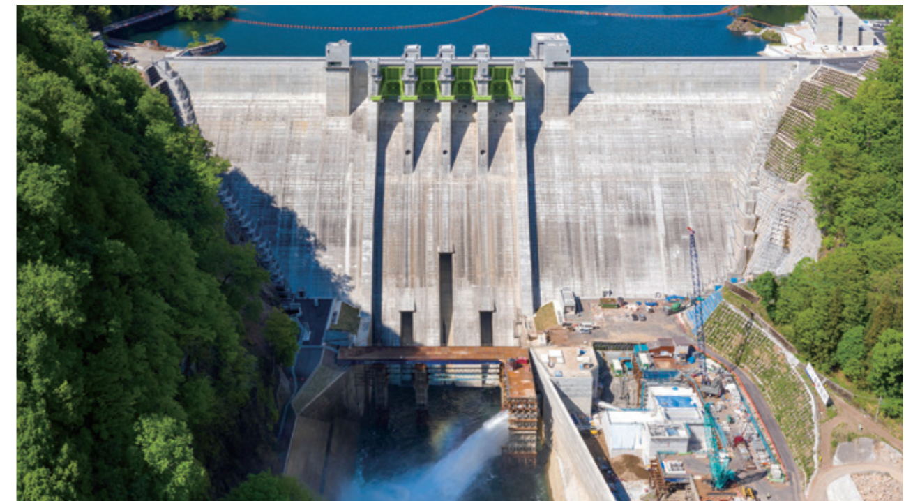
堤高116mの重力式コンクリートダム、ハッ場ダム(群馬県吾妻郡)
