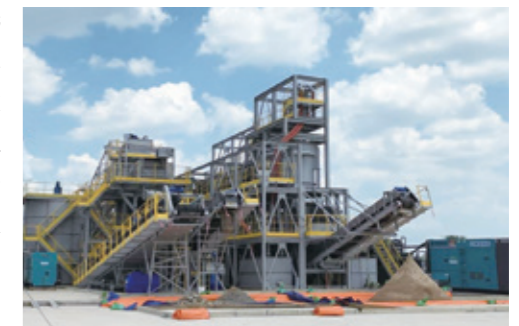
ビエンホア空港内ダイオキシン汚染土壌浄化プラント(ベトナム)
