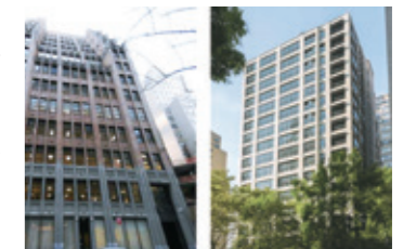
Albano Building(アメリカ)
