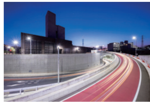
市街地における急勾配・急曲線・小土盛りの大断面シールドトンネルの建設(横浜北線馬場出入口)
