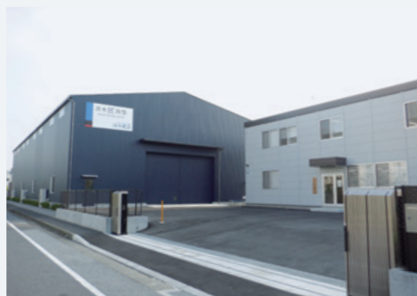
清水匠技塾の外観
