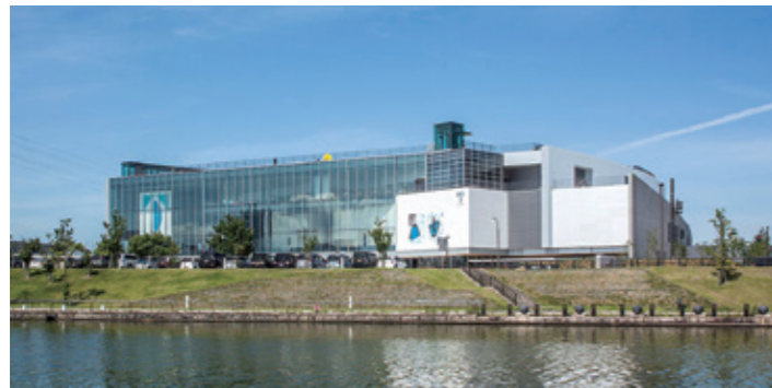
富山県美術館 (施工:当社 設計・監理:内藤廣建築設計事務所)
