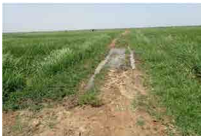
ロッソ灌漑地区における管理用道路
