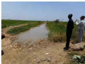
バガン灌漑地区における湛水した管理用道路
