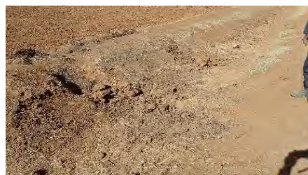
収穫機械の通過により破損した水路
