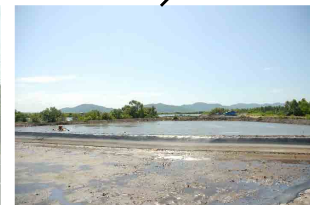
写真8 ブンタウ付近 (Km64+800)
