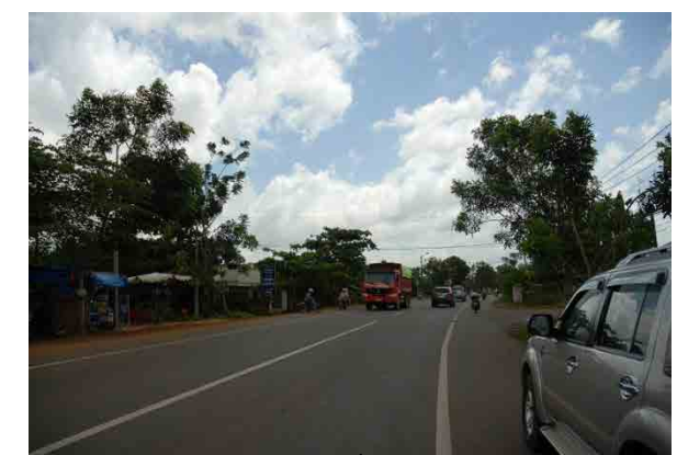
写真7 バリアIC付近 (Km53+800)
