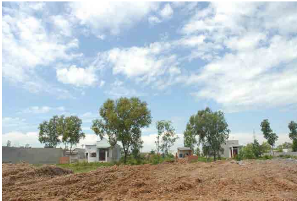
写真1 ビエンホア起点付近 (Km0+00)
