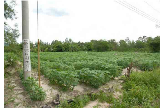
写真5 フーミーIC付近 (Km37+800)
