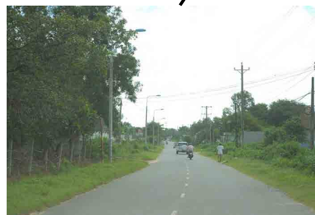
写真4 ノンチャックIC付近 (Km29+600)
