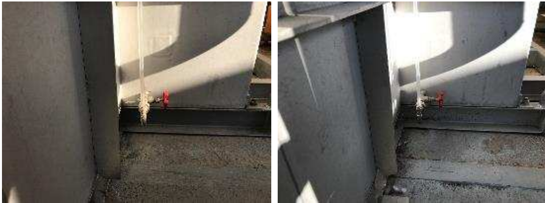
タンク水抜き状況（左：1号機、右：2号機）
