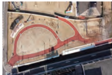
向東中央児童公園 (リニューアル整備工事)
