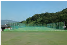
向島運動公園多目的広場 (整備工事)
