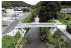
津田橋橋梁(災害復旧工事) YouTubeで作業動画見れます!!
