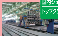
船体ブロック製造ライン
