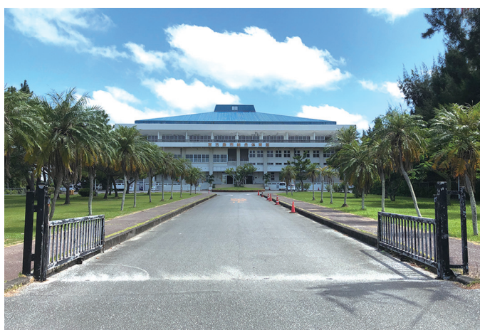
宮古島市総合体育館
