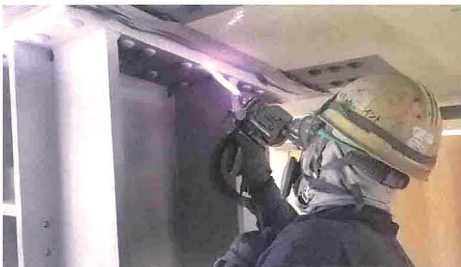
落橋防止装置への金属溶射 (アルミ・マグネシウム合金)
