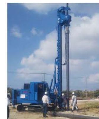
鋼管杭 杭打ち状況
