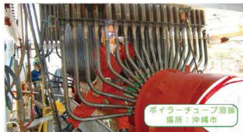
ボイラーチューブ溶接 場所：沖縄市
