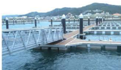
コンクリートフロート
