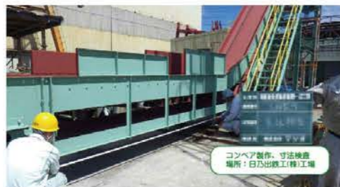
コンベア製作、寸法検査 場所：日乃出鉄工株式会社
