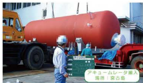
アキュームレータ搬入 場所：宮古島
