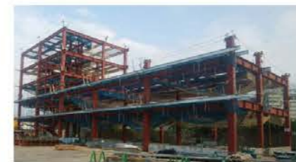
石垣真栄里ホテル 現場建方状況
