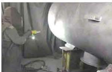
大きなオイルタンク側面へのプラスト施工状況
