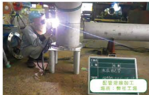
配管溶接加工 場所：豊後市
