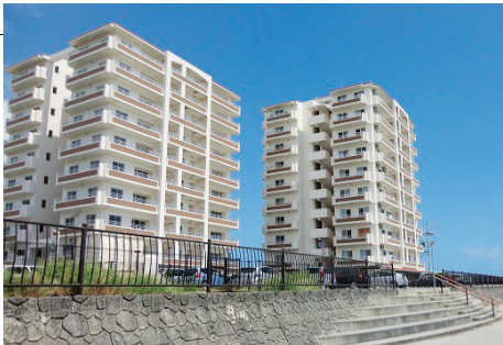
賃貸管理物件のうち約250室は自社物件だという。そのひとつである与那原町東浜のマンションは海にほど近い立地で見晴らしがよく、ショッピング施設も至近で便利
