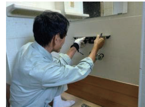
浴室シャワー水栓の取り付けをする川添さん
