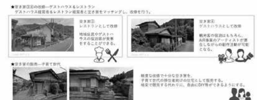
図9 空き家③④の改修と空き家販売
