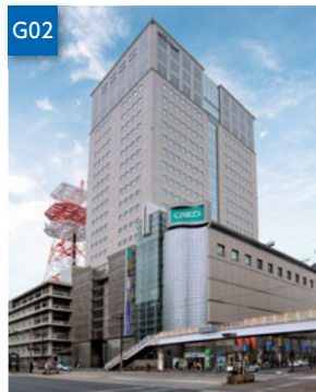
G02 NTTクレド岡山ビル (岡山市北区)
