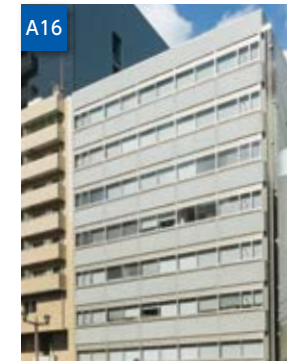
アーバンネット麹町ビル (千代田区麹町一丁目)
