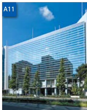
アーバンネット麻布ビル (港区南麻布一丁目)
