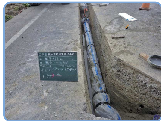
耐震管布設工事
