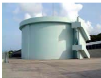
八重瀬第 3 配水池
