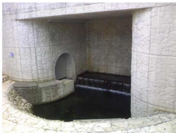
地下ダム放流口の様子
