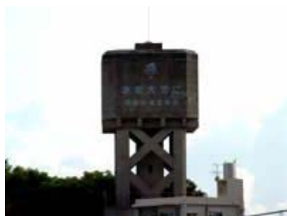
東風平配水池
