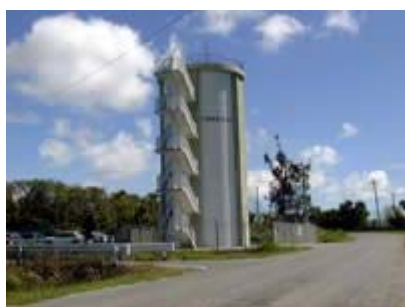
八重瀬第 2 配水池
