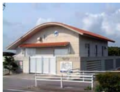
新城ポンプ場
